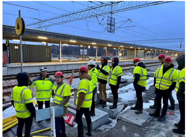
Geführte Baustellenbesichtigung der neuen Barkaby-Station
