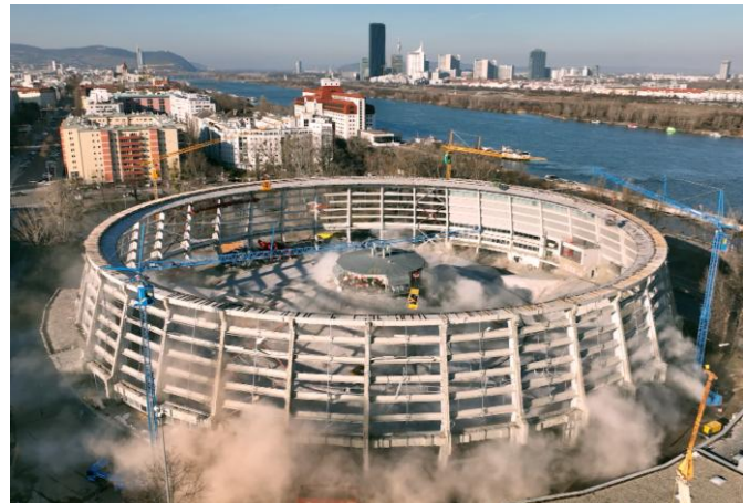
Rückbau Ferry-Dusika-Stadion in Wien 2022
