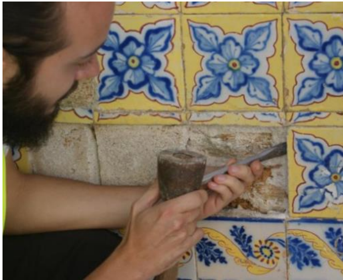
Abbildung 4: Restaurierungsarbeiten an einer Azulejo
