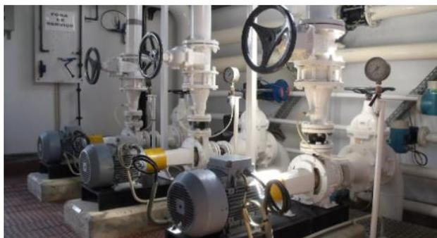
Abbildung 3: Horizontale Etachrom-Pumpen unterstützen die Verteilung von aufbereitetem Trinkwasser – die Anlage in Tavira verfügt über eine Aufbereitungskapazität von bis zu 2,2 m<sup>3</sup> pro Sekunde.
