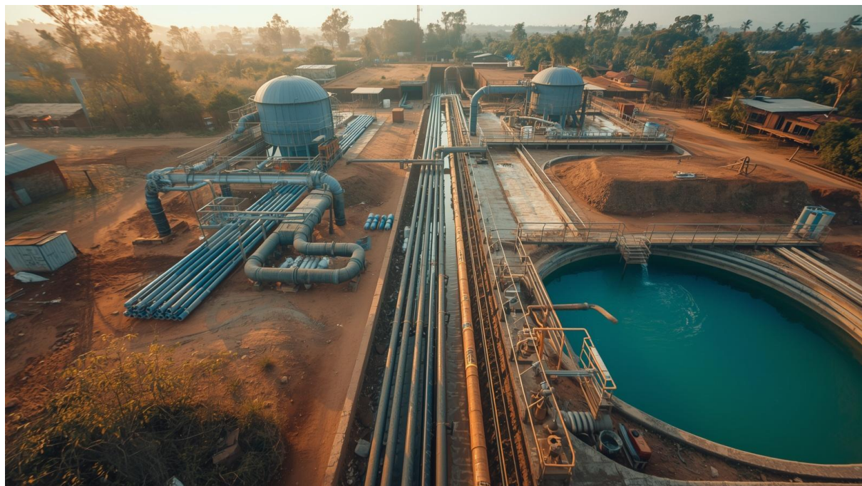
Beispielhafte Wasserinfrastruktur in Westafrika – Aufbereitung und Verteilungssysteme
