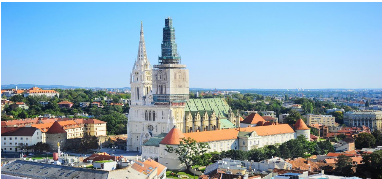
Zagreber Kathedrale (Dom Mariä Himmelfahrt und St. Stephan und Ladislaus), schwer beschädigt durch das Erdbeben im März 2020, Sanierung läuft; Quelle: iStock
