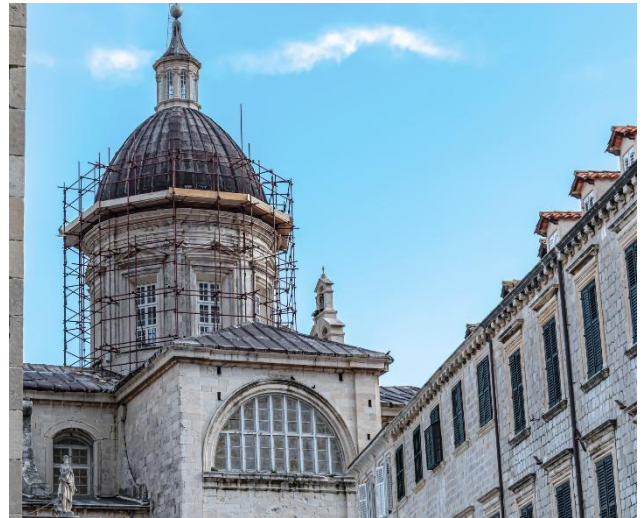
Sanierungsarbeiten in Dubrovnik; Quelle: iStock
