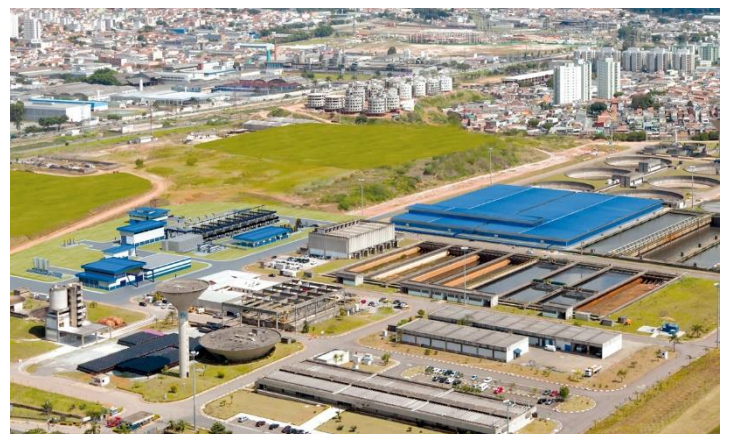
Aquapolo Anlage: Wasserwiederverwendung und Abwasserentsorgung im geschlossenen Kreislauf in São Paulo
