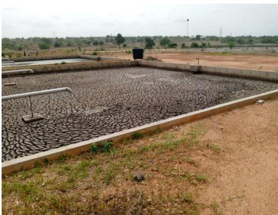
Schlamm-trocknung nach dem Entladen beim STBV in Bouaké
